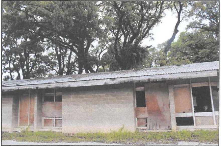
Foto Kantor Penelitian dan Pengembangan ( Research & Development Office ) Tampak Depan
