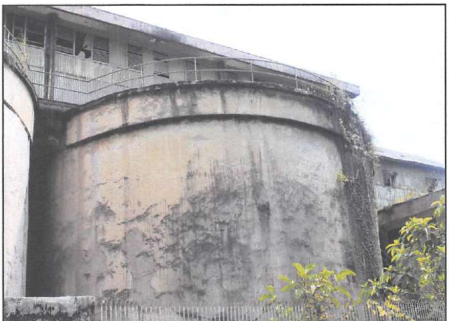
Foto Silo Semen A ( Cement Silo A ) Tampak Belakang (Sumber: Dok. Tim Pendaftar, 2022)
