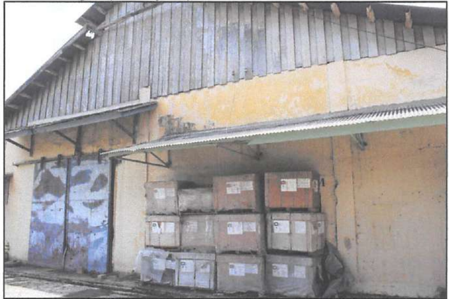
Foto Gudang 5 ( Storage 5 ) Tampak Depan
