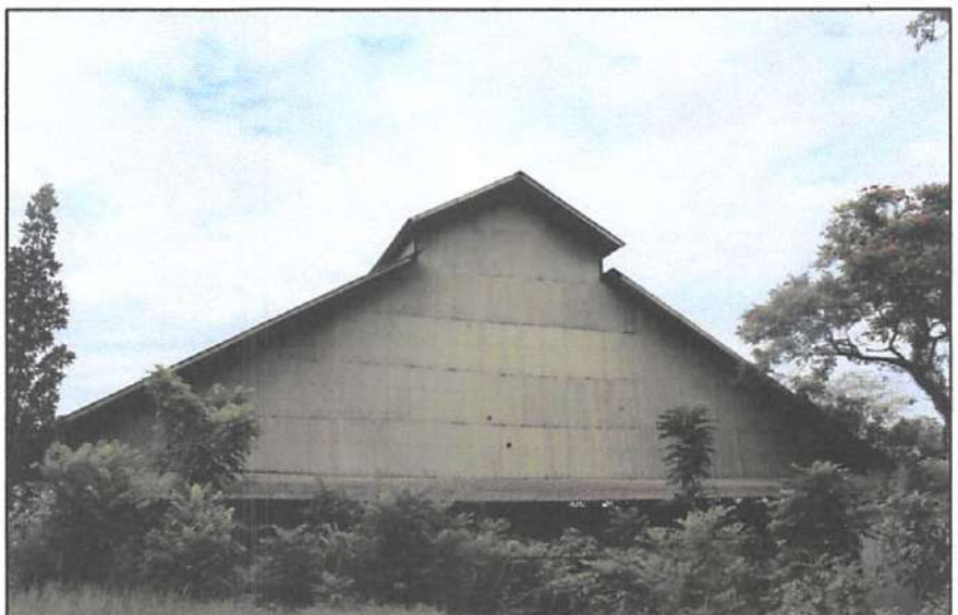
Foto Bengkel Listrik ( Electrical Workshop ) Tampak Samping Kanan (Sumber: Dok. Tim Pendaftar, 2022)
