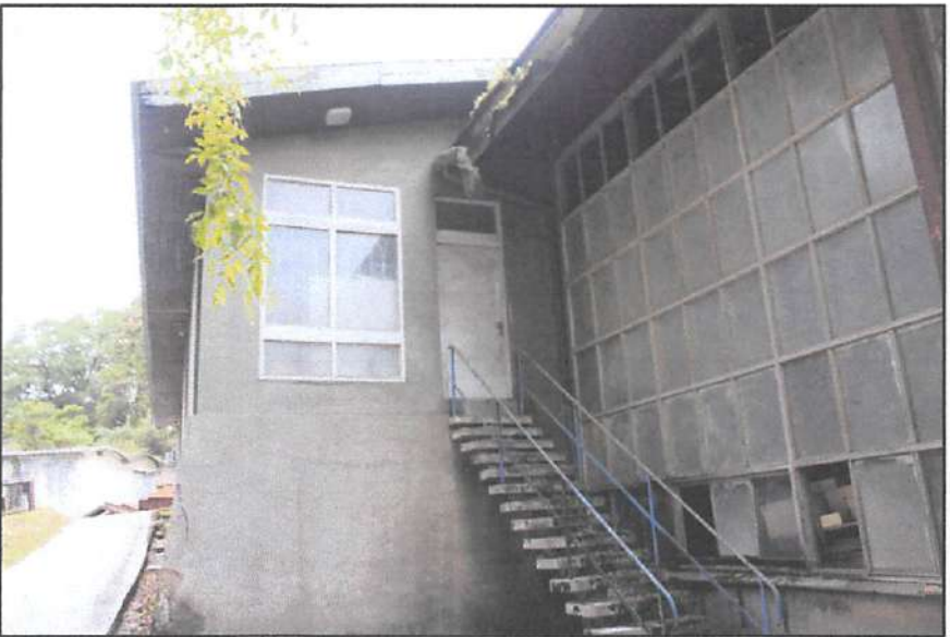
Foto Kantor Sipil ( Civil Office ) Tampak Belakang (Sumber: Dok. Tim Pendaftar, 2022)
