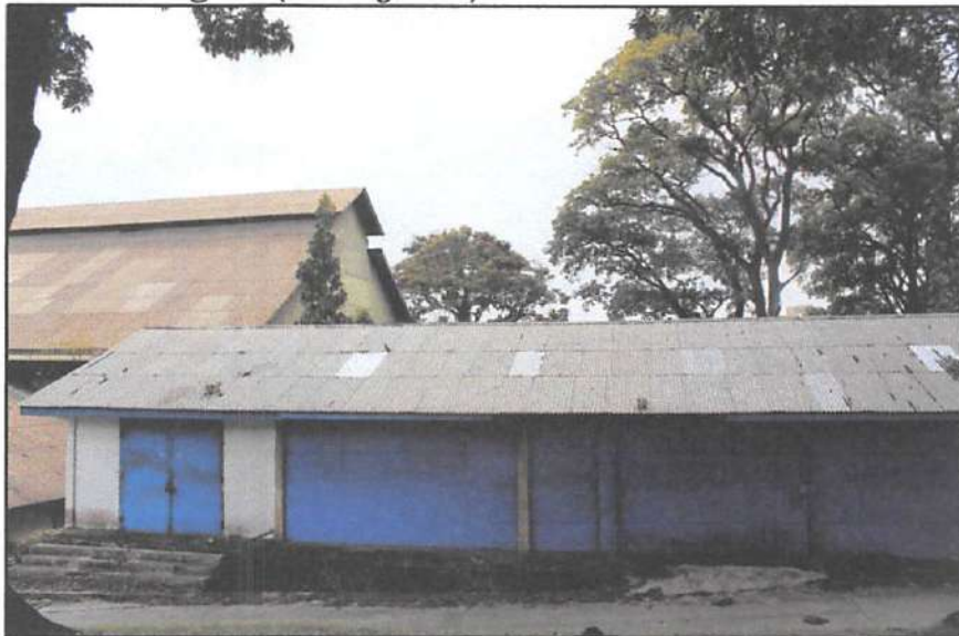
Foto Gudang 30 ( Storage 30 ) Tampak Depan
