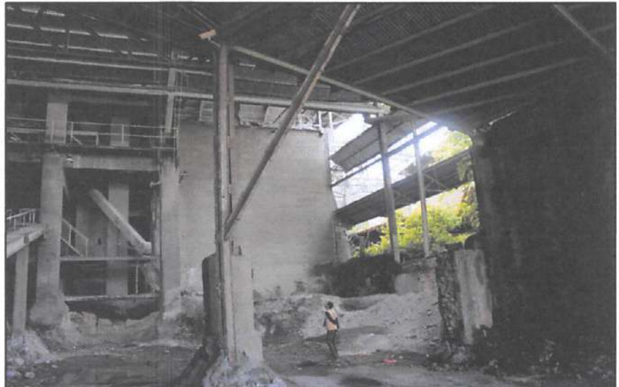
Foto Stasiun Kereta Gantung ( Cableway station ) Indarung-Bkt. Putus Tampak Dalam
