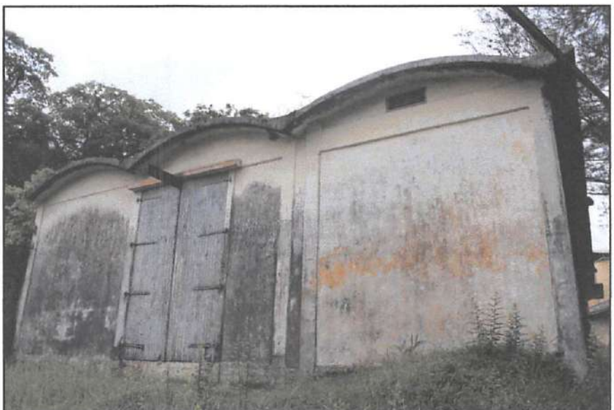
Foto Penyimpanan Suku Cadang Listrik ( Storage Electrical Spare Part ) Tampak Depan (Sumber: Dok. Tim Pendaftar, 2022)
