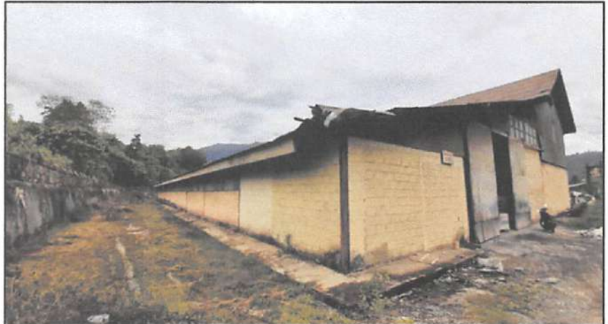
Foto Gudang 1 ( Storage 1 ) Tampak Depan
