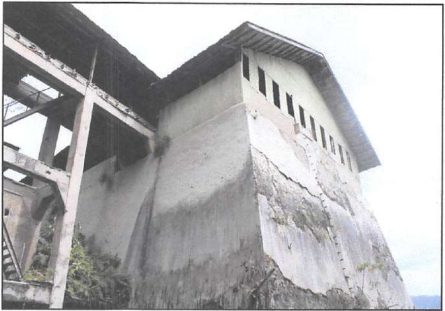
Foto Silo Batu Bara ( Coal Silo ) Tampak Samping (Sumber: Dok. Tim Pendaftar, 2022)
