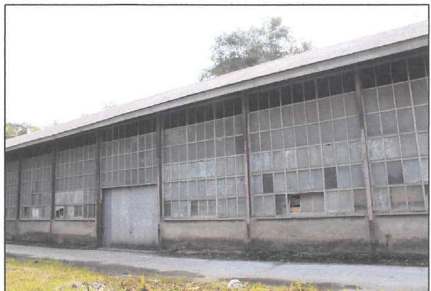
Foto Pabrik Pembuatan Tas ( Bag Manufacturing Plant ) Tampak Depan (Sumber: Dok. Tim Pendaftar, 2022)
