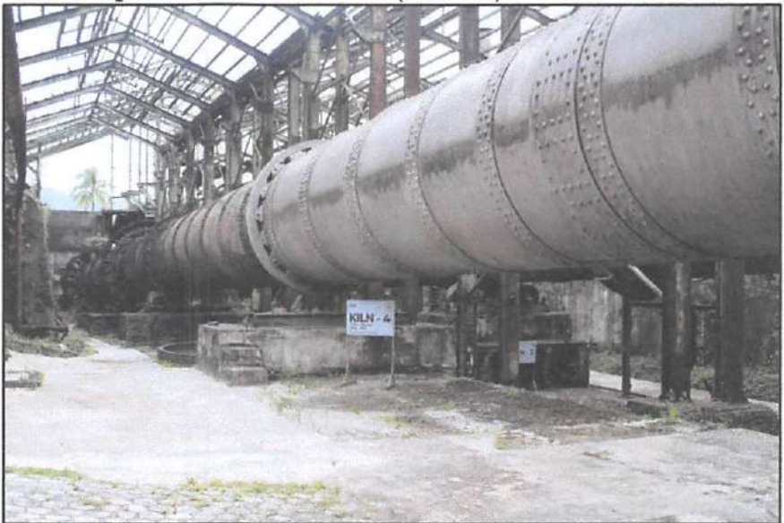
Foto Tempat Pembakaran IV ( Kiln IV ) Tampak Depan
