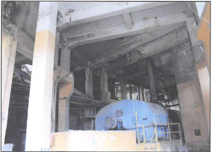
Foto Pabrik Semen ( Cement Mill I, II, III, IV, V ) Tampak Dalam (Sumber: Dok. Tim Pendaftar, 2022)
