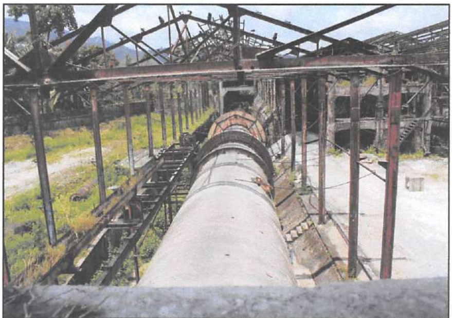
Foto Tempat Pembakaran V ( Kiln V ) Tampak Atas (Sumber: Dok. Tim Pendaftar, 2022)
