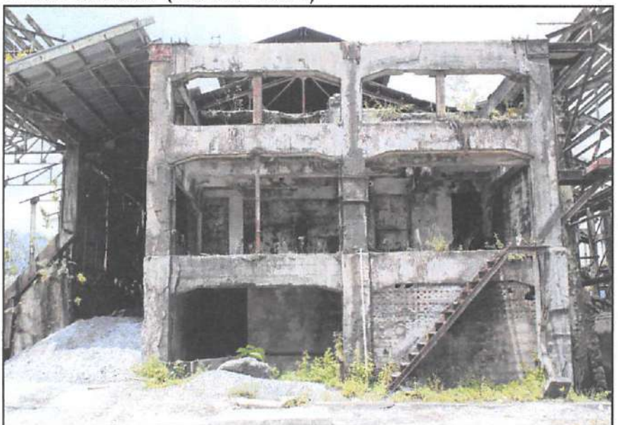
Foto Silo Klinker ( Clinker Silo I ) Tampak Depan
