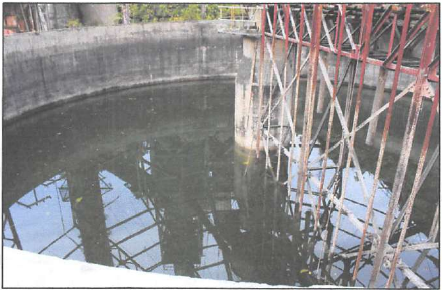
Foto Bak Bubur A ( Slurry Bassin A ) Tampak Atas (Sumber: Dok. Tim Pendaftar, 2022)
