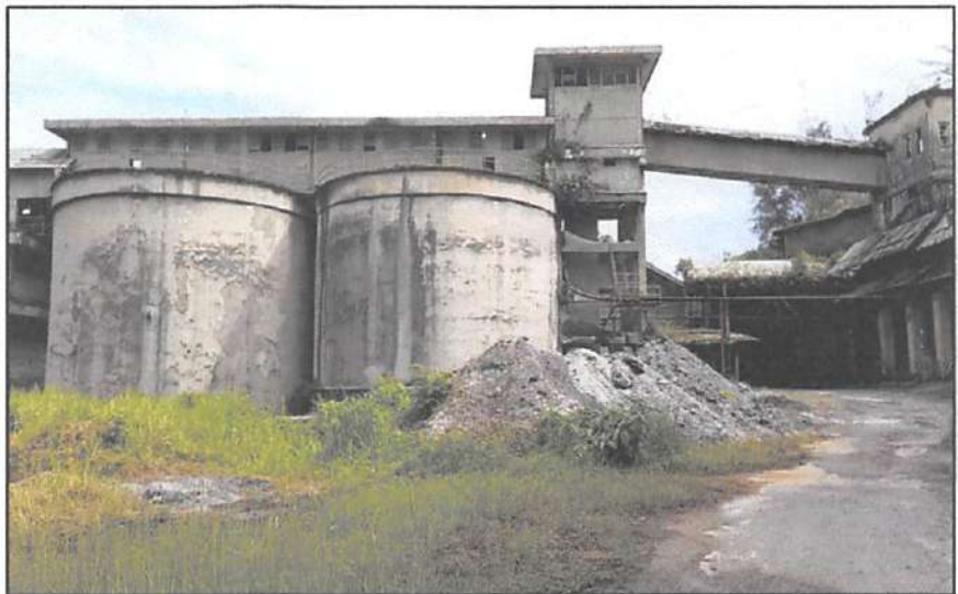
Foto Bekas Bengkel Kereta ( Cableway Workshop ) Tampak Samping (Sumber: Dok. Tim Pendaftar, 2022)
