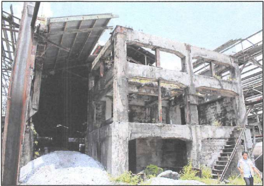
Foto Silo Klinker ( Clinker Silo I ) Tampak Samping (Sumber: Dok. Tim Pendaftar, 2022)
