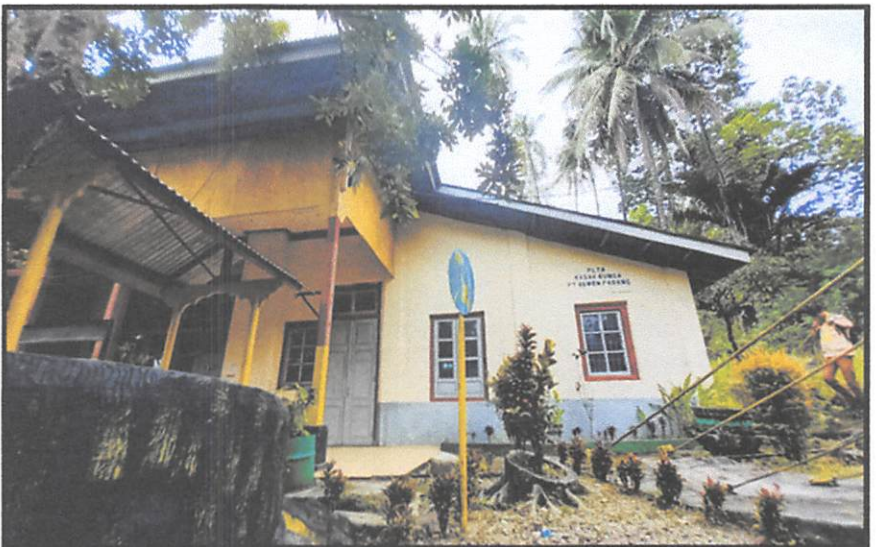
PLTA Rasak Bungo Tampak Depan Sisi Kanan (Sumber: Dok. Tim Pendaftar, 2022)
