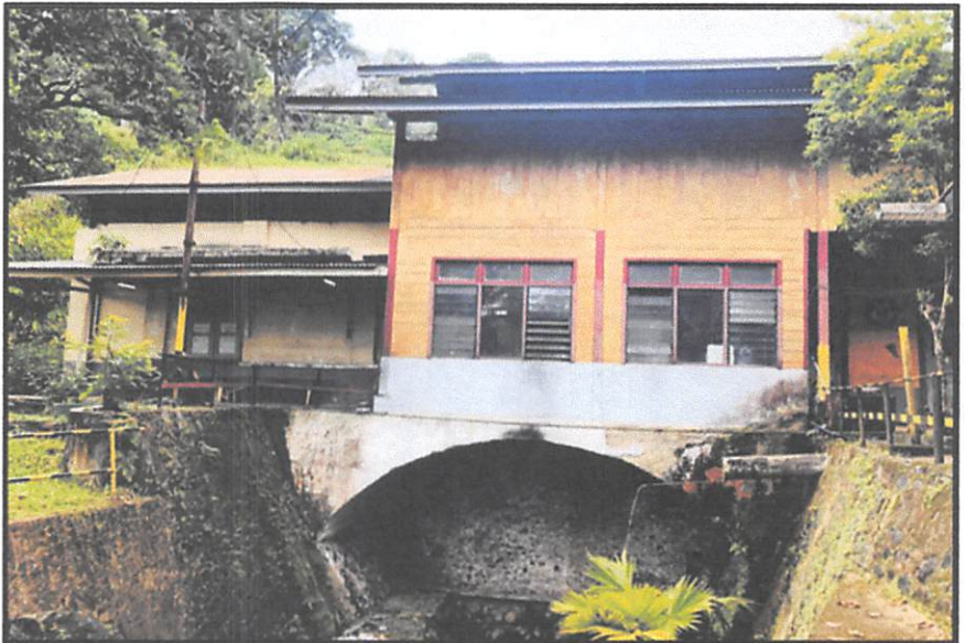
PLTA Rasak Bungo Tampak Depan Sisi Kiri (Sumber: Dok. Tim Pendaftar, 2022)
